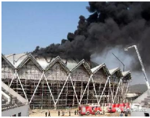
施工现场外脚手架失火案例
