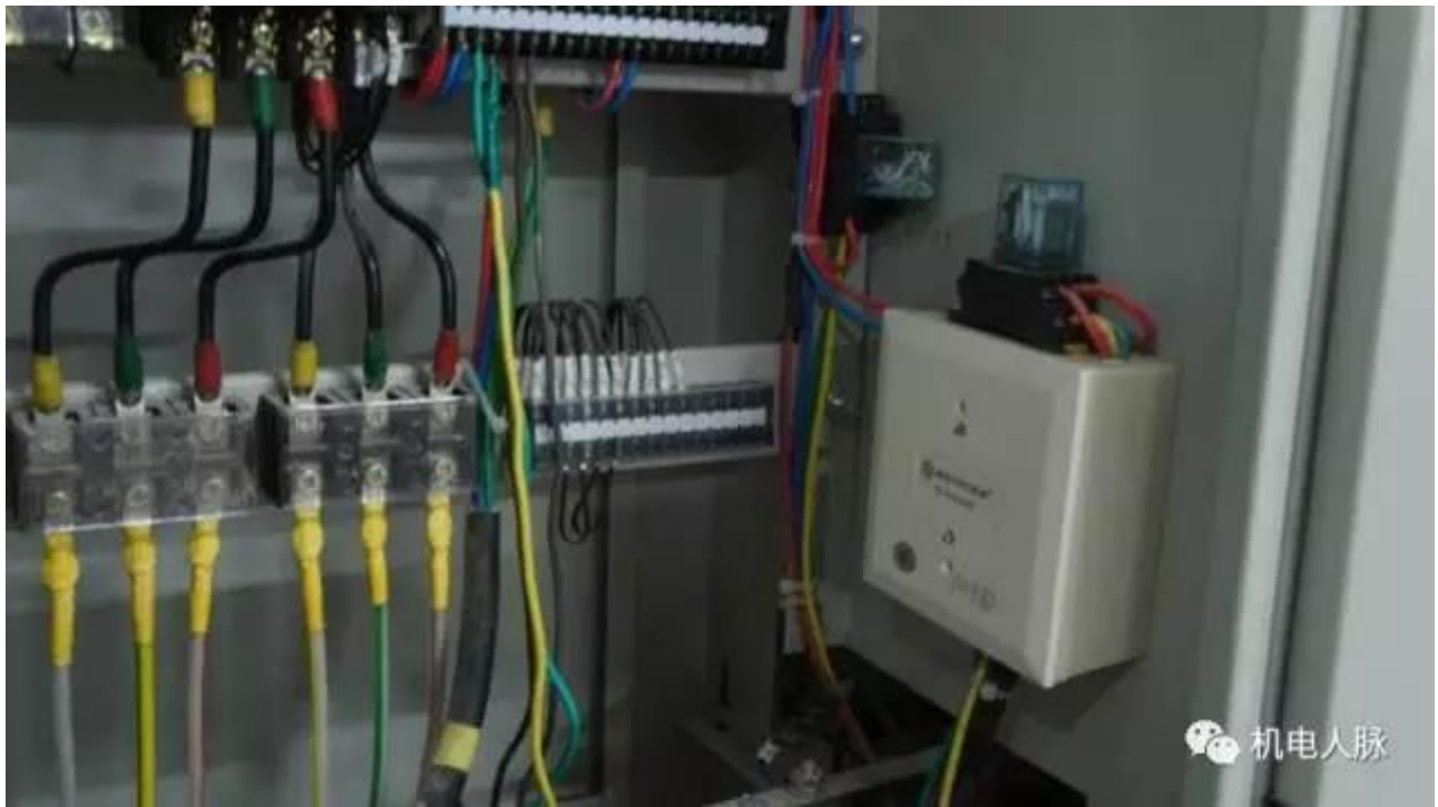
图6.2.4控制模块不应装与配电柜内
