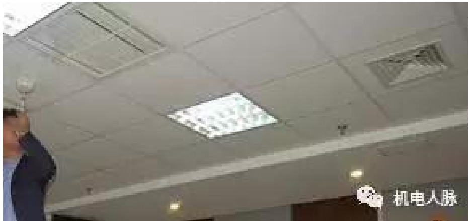
图6.2.2-1 探测器远离送风口安装
