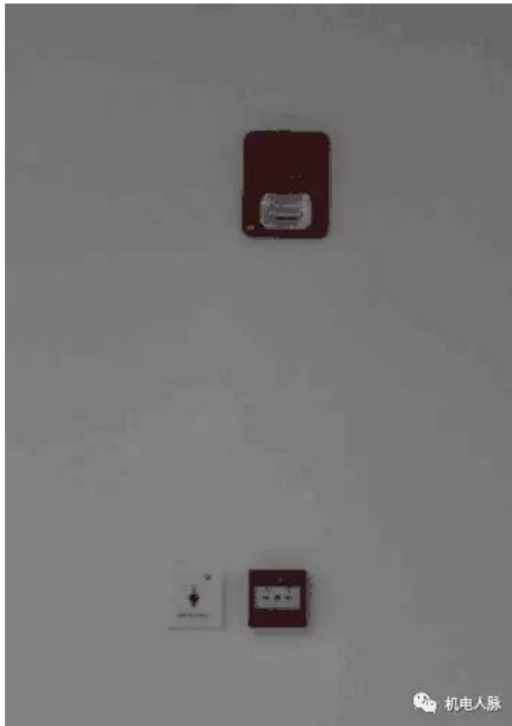
图6.2.7火灾光警报装置安装
